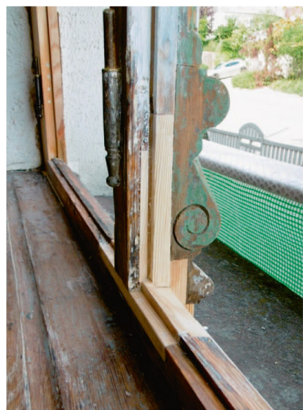
Abb. 2b: Eingesetzte Reparaturteile. Im Hintergrund das für die Durch- führung der Arbeiten demontierte Baufenster. (Foto: B. Münchow)
