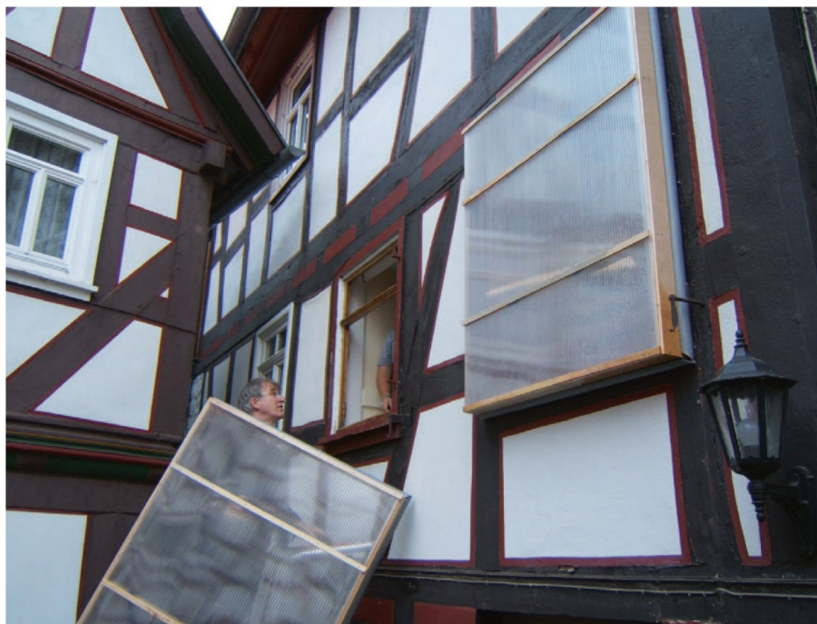
Abb. 3: Entfernung der Baufenster nach Instandsetzung der Fensterflügel in der Werkstatt.
