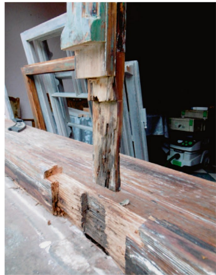
Abb. 2a: Detail einer in situ-Reparatur im Bereich unteres Rahmenholz/Setzholz. (Foto: B. Münchow)
