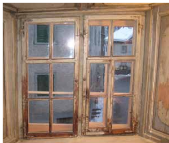
Originalfenster in der unteren Stube im Turalihus vor der Instandsetzung. Durch frühere Setzungen am Haus haben sich die Fensterstock und Blendrahmen trapezförmig verzogen, die Flügel hatten sich herausgedrückt.
